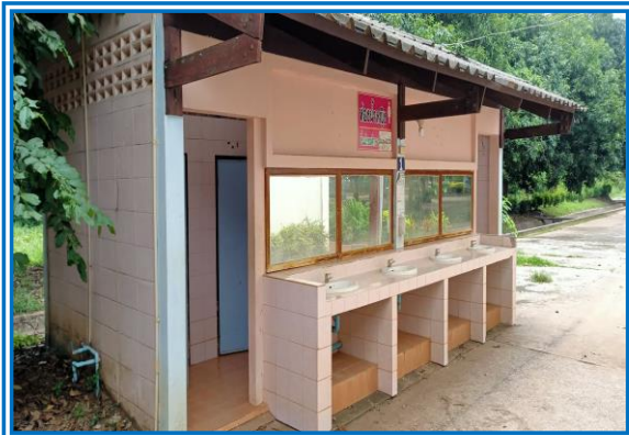
ส้วม ส้วมมาตรฐาน 6 ที่นั่ง /27 : ปีที่สร้าง 2536
