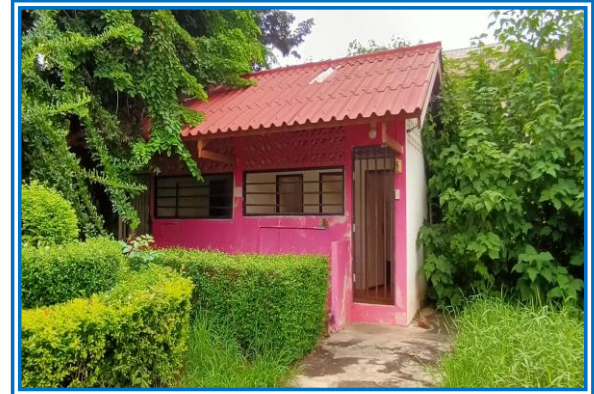
ส้วม ส้วมมาตรฐาน 6 ที่นั่ง /27 : ปีที่สร้าง 2539
