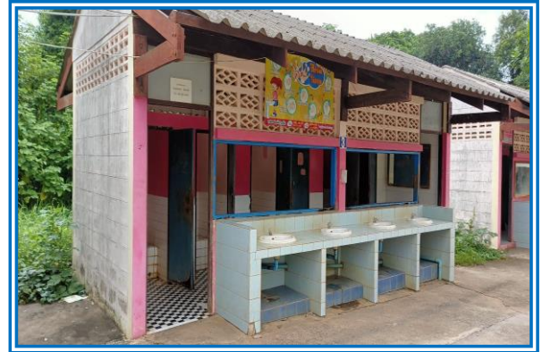
ส้วม ส้วมมาตรฐาน 6 ที่นั่ง /27 : ปีที่สร้าง 2538
