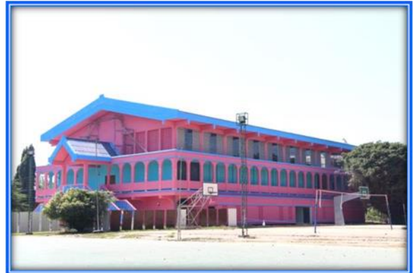
อาคารอเนกประสงค์/โรงอาหาร/โรงฝึกงาน อาคารหอประชุม -โรงอาหาร 101 ล./27, 101ล/27(พิเศษ) : ปีที่สร้าง 2559
