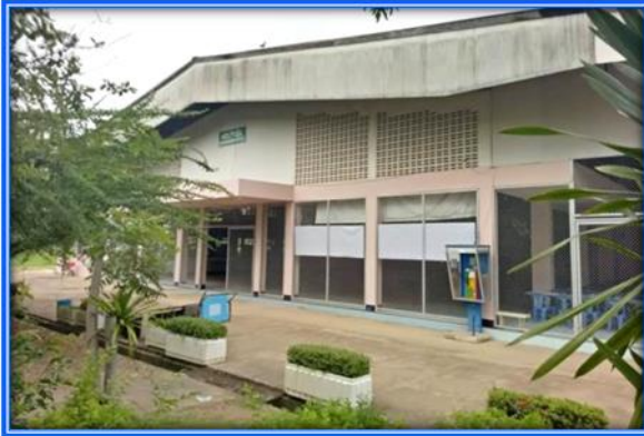
อาคารอเนกประสงค์/โรงอาหาร/โรงฝึกงาน 005, ป005 : ปีที่สร้าง 2524
